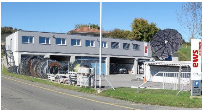
Bild 02_ EWS Energie AG, Reinach AG
