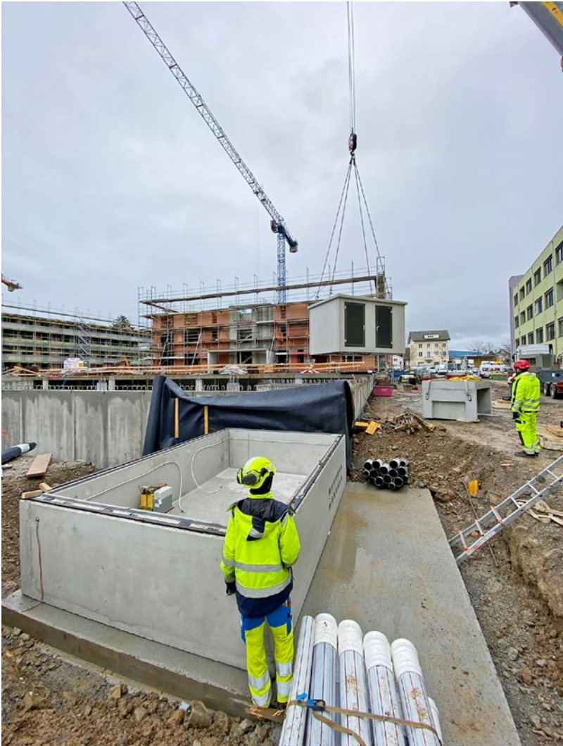
Im Weihermattpark entstehen aktuell über 140 Wohnungen. Damit alle mit Strom versorgt werden, muss das Netz mittels neuer Trafostationen ausgebaut werden.
